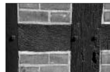
Sorgfältig restauriertes Fachwerk
